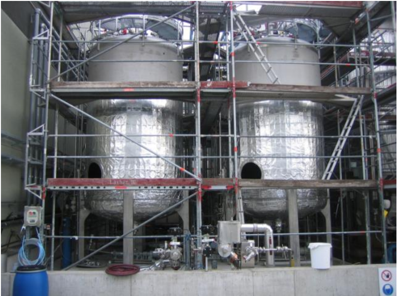
Bild 1: Tanklager während der Montage
