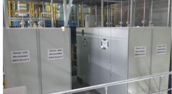
Bild 2: Misch- u. Steuermodule für 4 Linien
