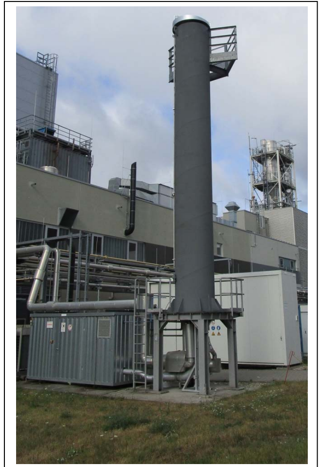
Bild 3: Ausführung nach Umbau
